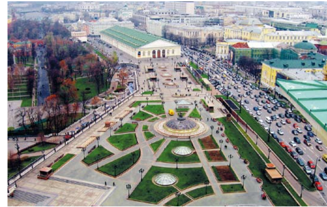
Гидроизоляция подземной части ТК «Охотный Ряд», на Манежной площади – 25 тыс. м 2 .
