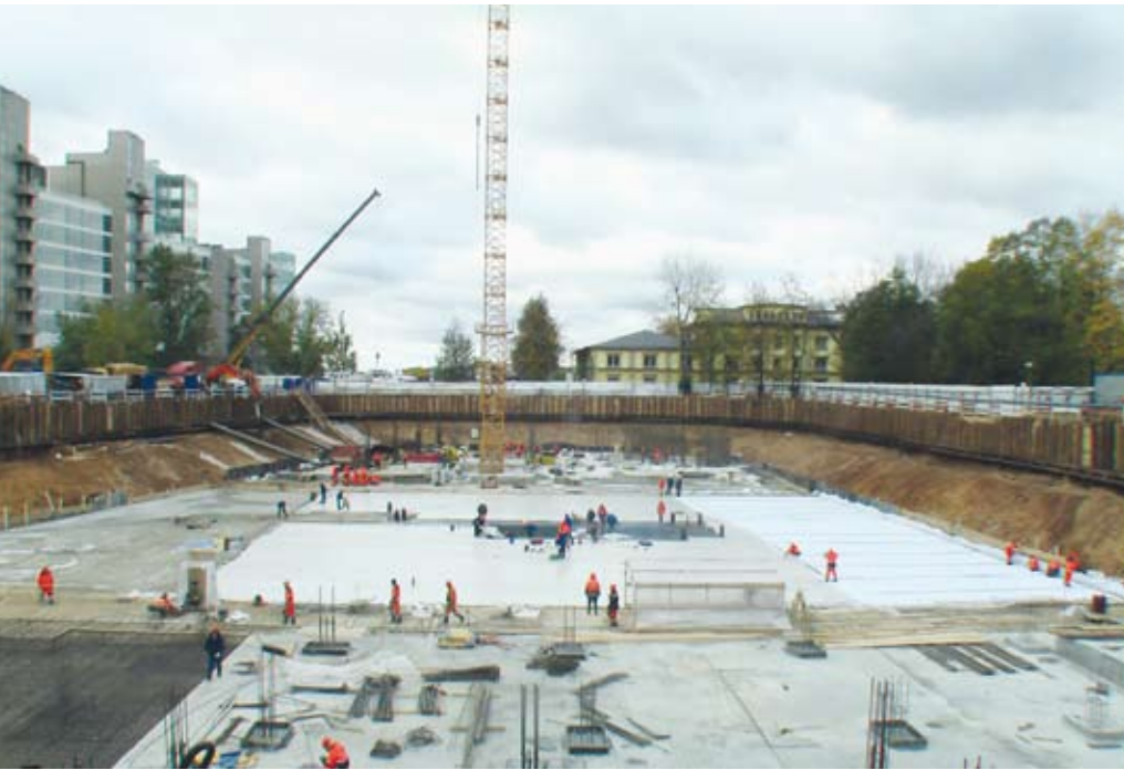
Гидроизоляция подземной части Центра «DoubleTree BY Hilton Hotel Moscow – Marina» – 14 тыс. м 2 .
