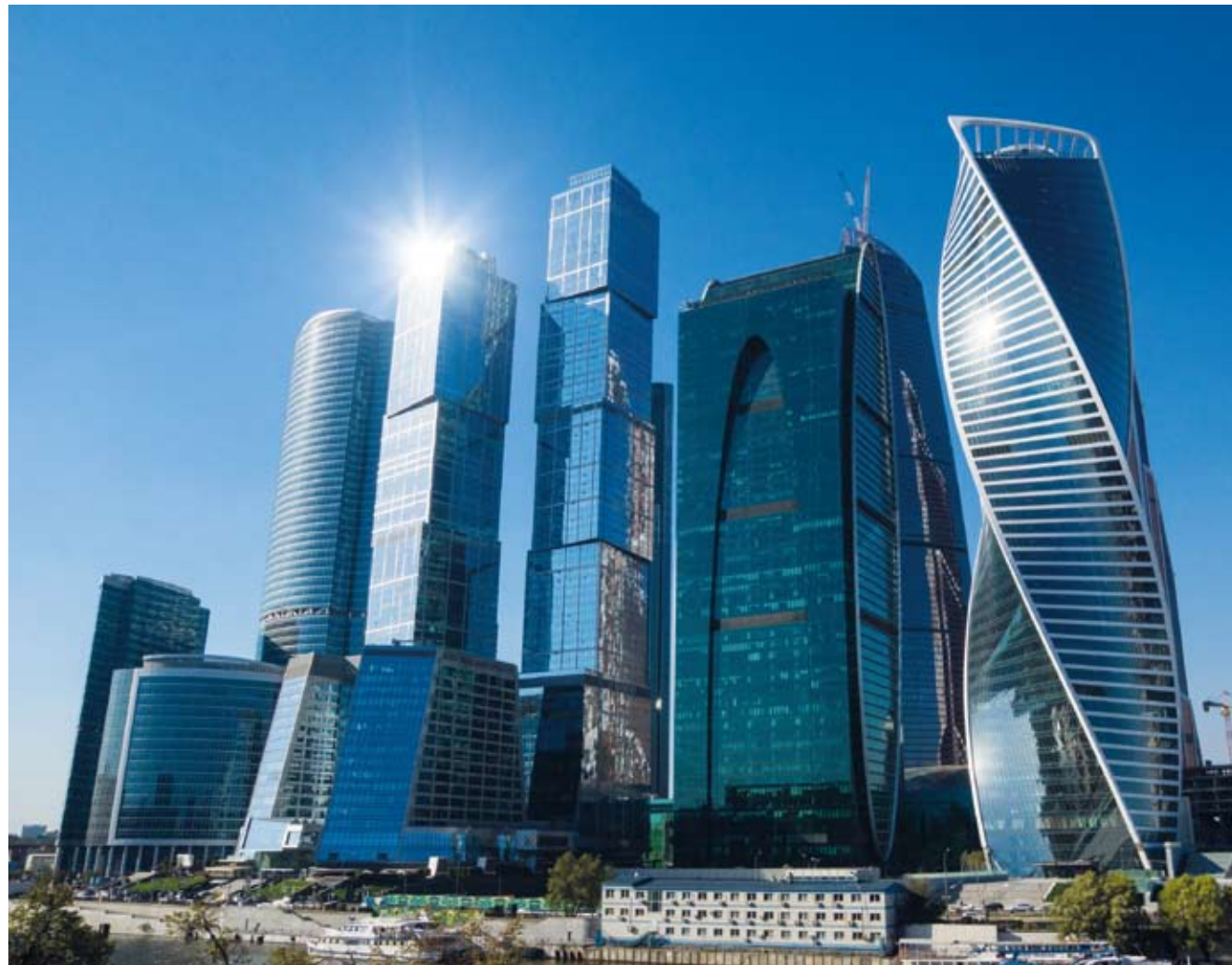
Гидроизоляция подземной части комплекса «Москва Сити», ТРК «Афимолл Сити» – 150 тыс. м 2 .
