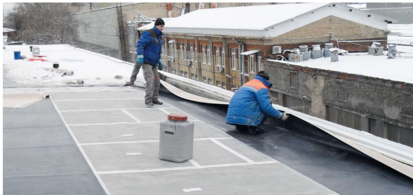
Элон-Супер Л укладка в зимних условиях
