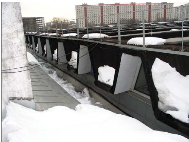
Рис. 8. Отсутствие наледей на юго-восточных торцах складок. Состояние после ремонта кровли. Весна 2010 г.
