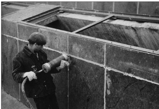
Рис. 3. Герметизация швов тиоколовым герметиком УТ-32. 1970 г.
