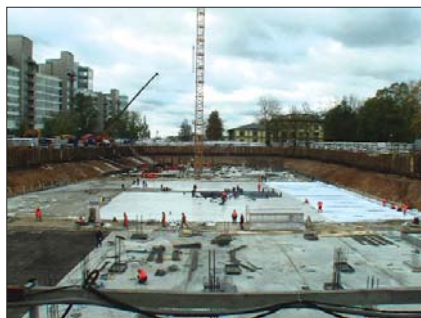
Рис. 2. Общий вид на работы по устройству горизонтальной гидроизоляции многофункционального комплекса на Ленинградском шоссе в Москве
