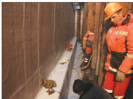
Рис. 4. Ведение гидроизоляционных работ в узких пазухах между шпунтовым ограждением котлована и вертикальными железобетонными стенами заглубленной части многофункционального комплекса, расположенного на Ленинградском шоссе в Москве
