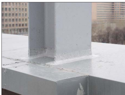
Рис. 5. Гидроизоляция основания стальной стойки мастикой Унимаст
