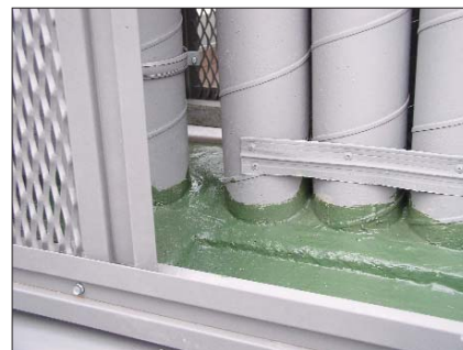
Рис. 6. Гидроизоляция вентиляционных выходов мастикой Унимаст
