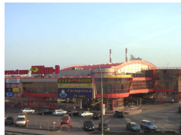
Торговый центр Три Д
